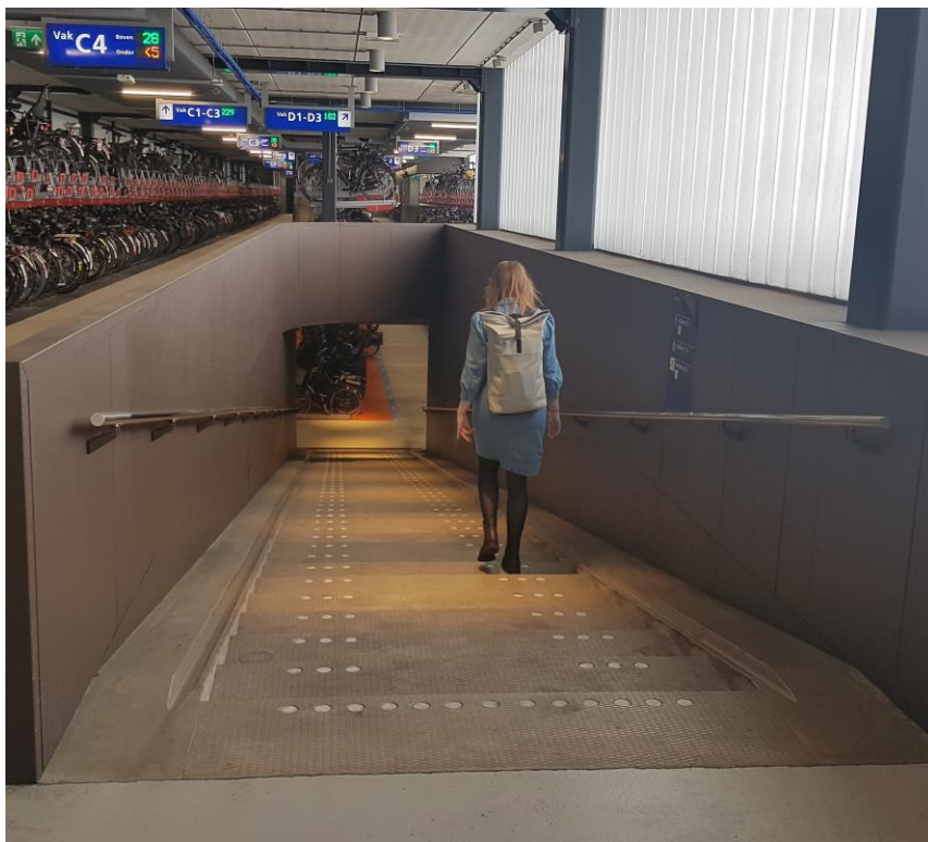
ESCALIERS DE FAIBLE PENTE ÉQUIPÉS DE GOULOTTES
